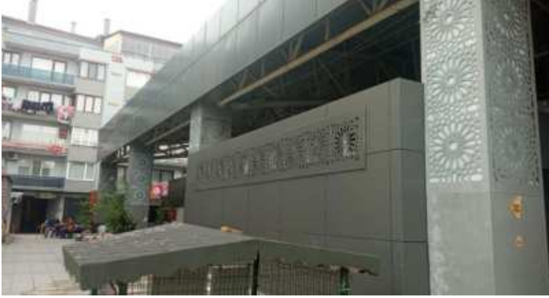
Adnan Menderes Meydanı Tuvalet Yapım İşi
