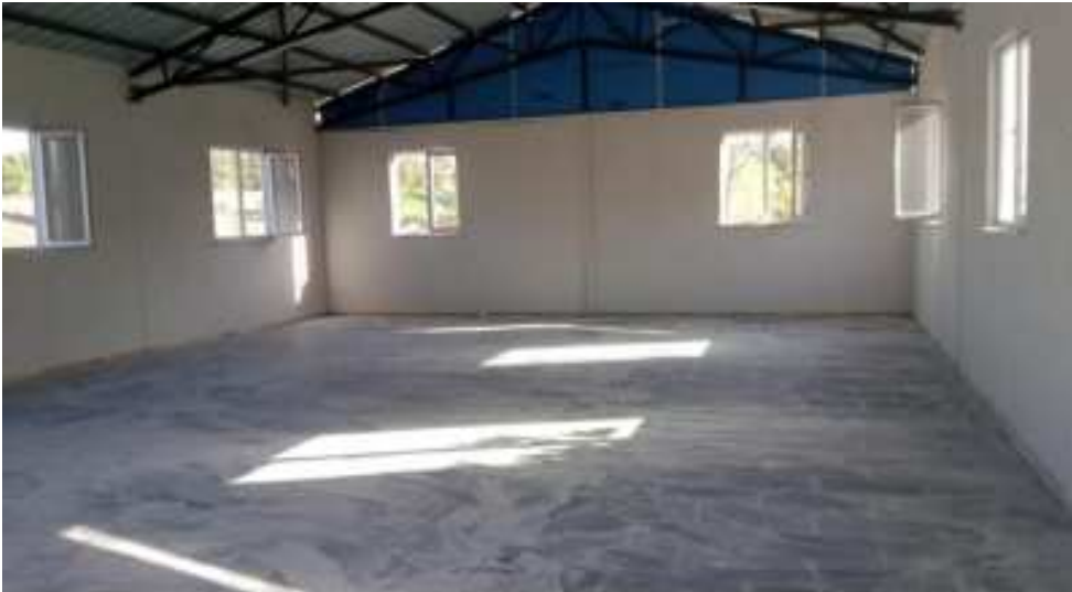
Uğurlupınar Mahallesi Düğün Salonu Yapım İşi
