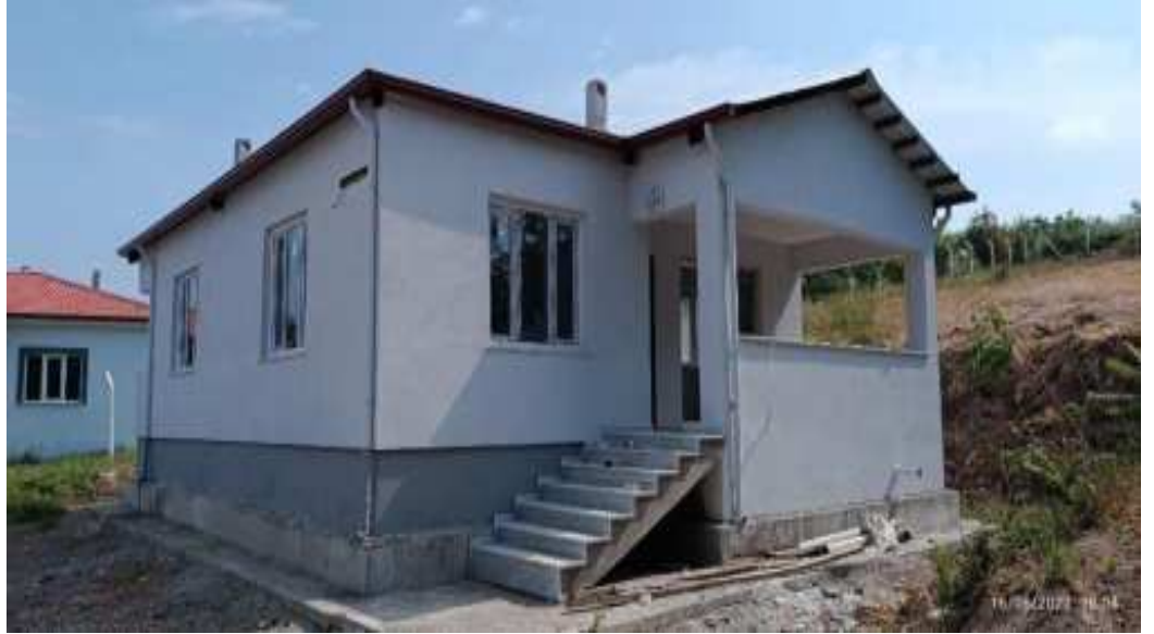
Boğaz Köy Mahalle Konağı Yapım İşi
