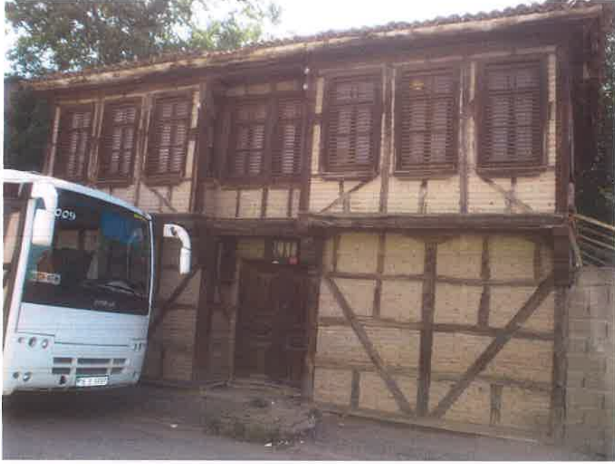
Şekil 4: 35 envanter no ile tescilli yapı
