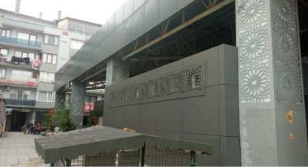
Adnan Menderes Meydanı Tuvalet Yapım İşİ
