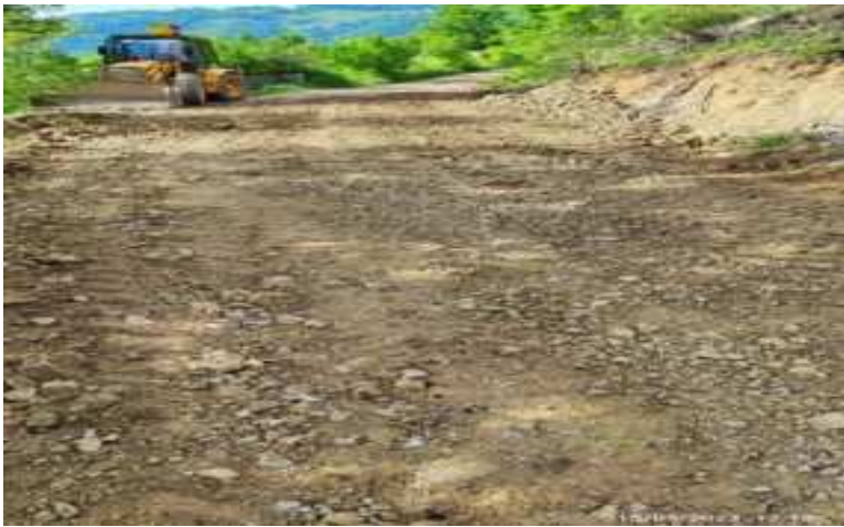
Arazi ve yol çalışmaları
