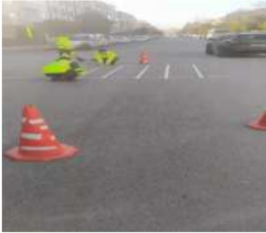
Resim 8-9: Yol ve altyapı çalışmalarında gerekli önlemler alınmaktadır.
