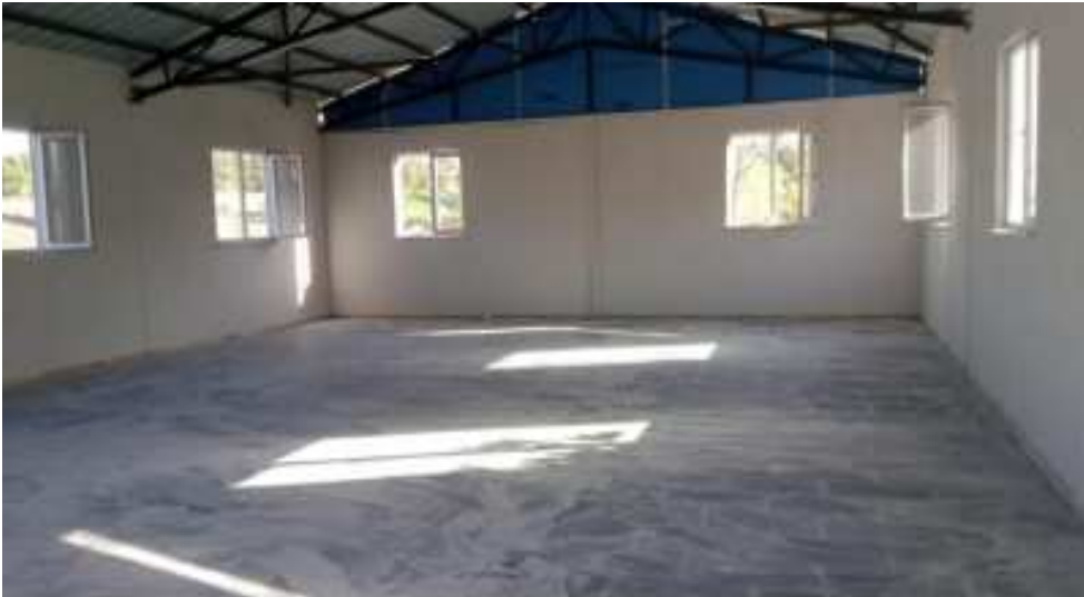
Uğurlupınar Mahallesi Düğün Salonu Yapım İşİ
